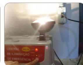
**6** Posicione o equipamento de maneira que os projetores não ofusquem a visão. Efetue um teste pressionando a tecla na posição "teste/liga" (fig.02), os projetores serão ativados por aproximadamente 4 segundos
